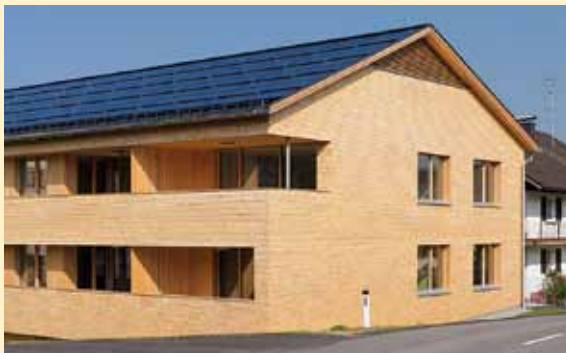
Dachintegrierte Solarstromanlage in Krumbach: ein Gewinn für alle.
